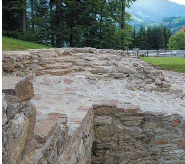
*Die Altburgstelle in Schwanberg: rechts Kanonenrondell aus dem Spätmittelalter; links oben das Ende der Mauer im Osten, links unten die Turmrundung*
