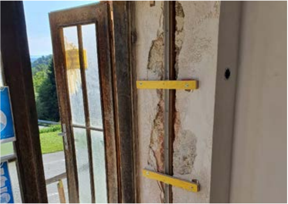
Unterkonstruktion Eingangstür © eaw
