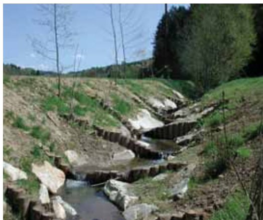
Bachrenaturierung: Rückbau eines Wanderhindernisses
