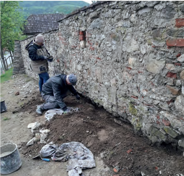
Restaurierung einer Kirchhofmauer
