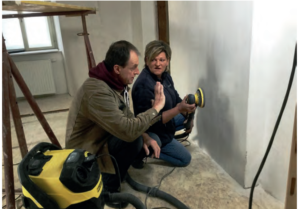
Schleifen der Wände
