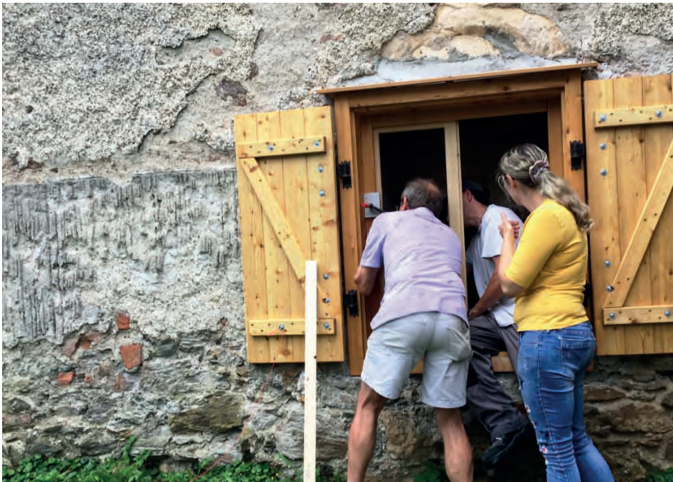
Einsetzen der Fenster
