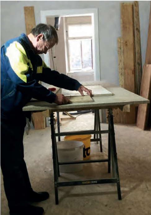
Herstellung der Türen in Vollholzbauweise
