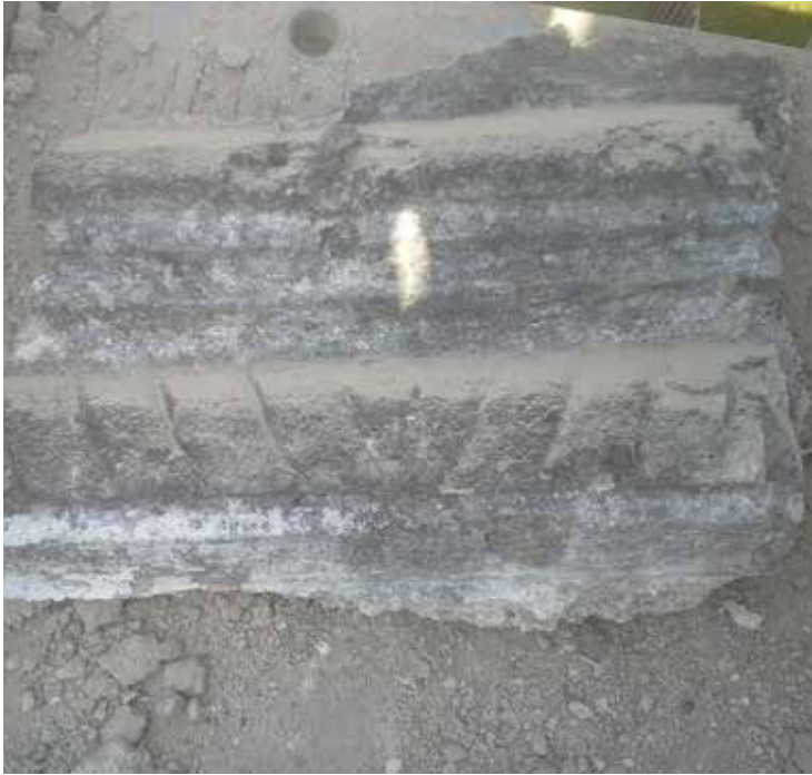
Restaurierung: Fassadenelement vorher
