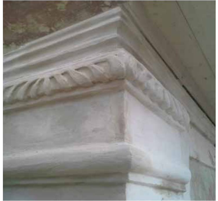
Restaurierung: Fassadenelement nachher
