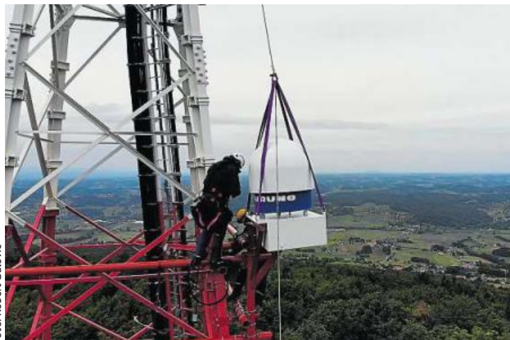
Die Installation eines Wetterradars für das WegenerNet
