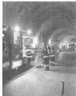
Übung in einem der bereits ausgebauten Tunnelabschnitte
